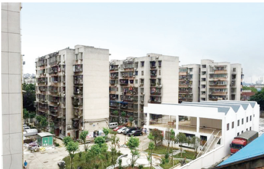
2018 年 2 月,柳州市完成 30 个企业老旧危房改造。图为狮山路 3 号小区改造后的景象 (市住建委提供)
